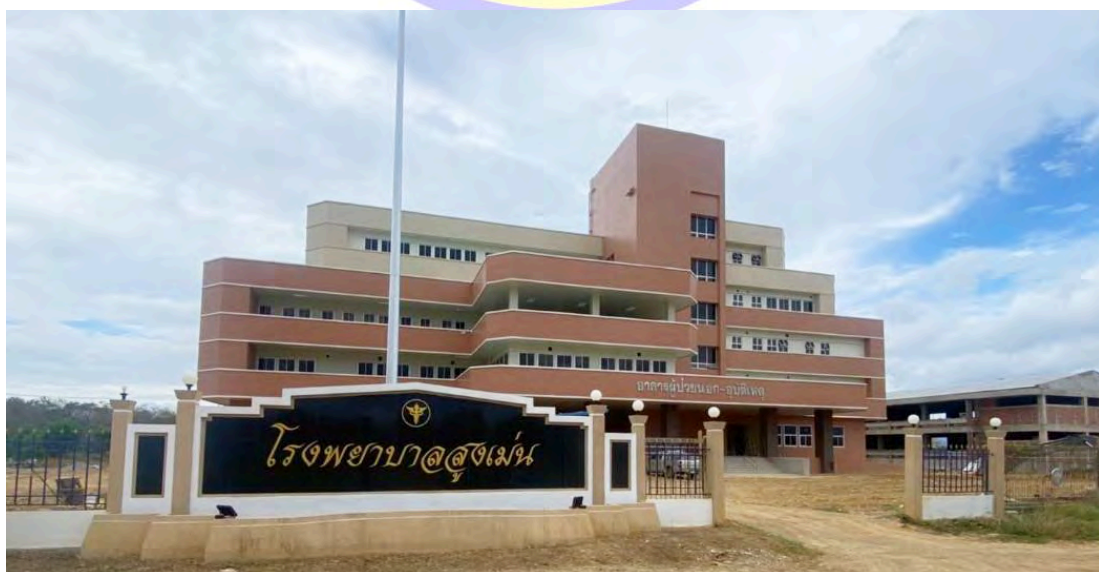
Construction of Sung-Men, Hospital ( รพ.สูงเม่น จ.แพร่ )
